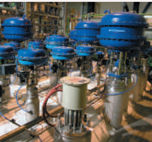
Vannes cryogéniques équipées de servomoteurs pneumatiques Pneumatic actuators on cryogenics valves
