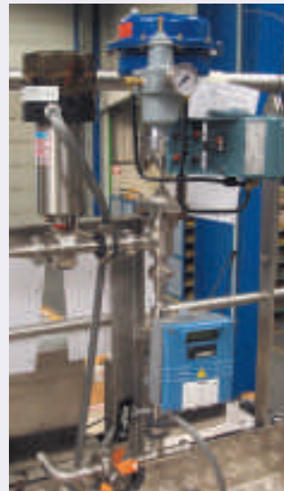
Débitmètres électromagnétiques installés en industrie agroalimentaire Electromagnetic flowmeters installed on food industry process
